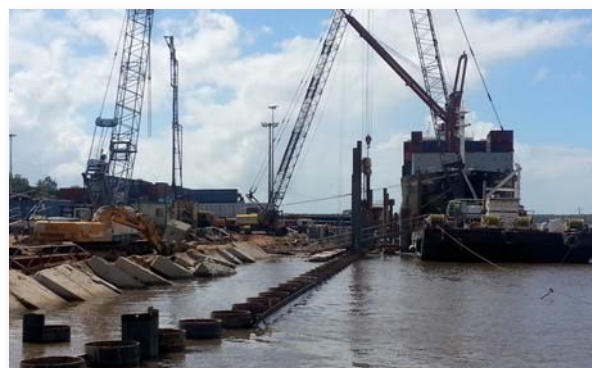
Quai n°2 en travaux
