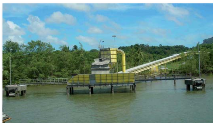
Quai minéralier exploité par Les Ciments Guyanais.
