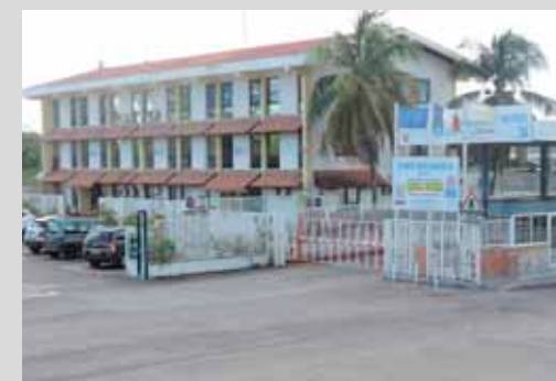
▲ Entrée Porte des quais A
