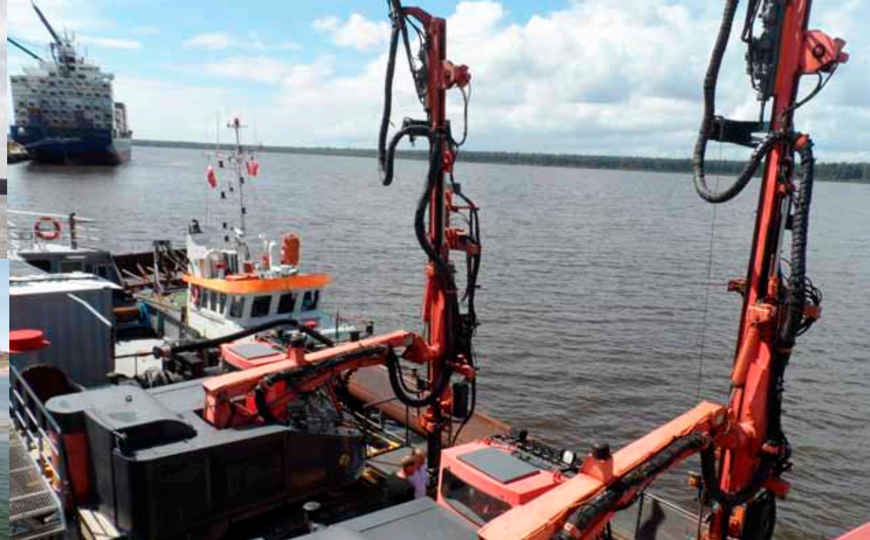
▲ Foreuses montées sur drague pour travaux de déroctage
