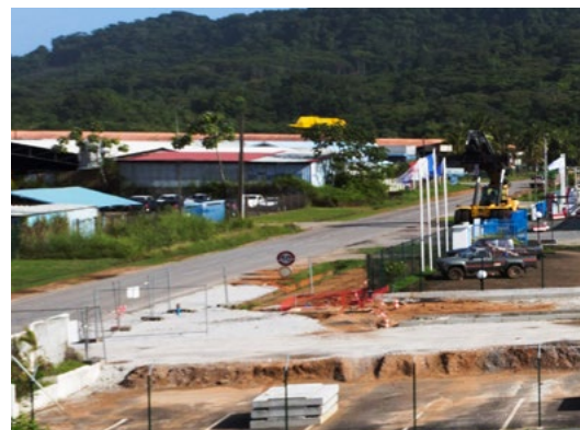
Travaux Complexe entrée-sortie
